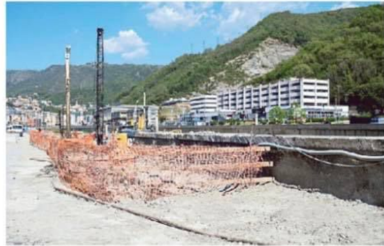
Il cantiere dello scolmatore del Bisagno
